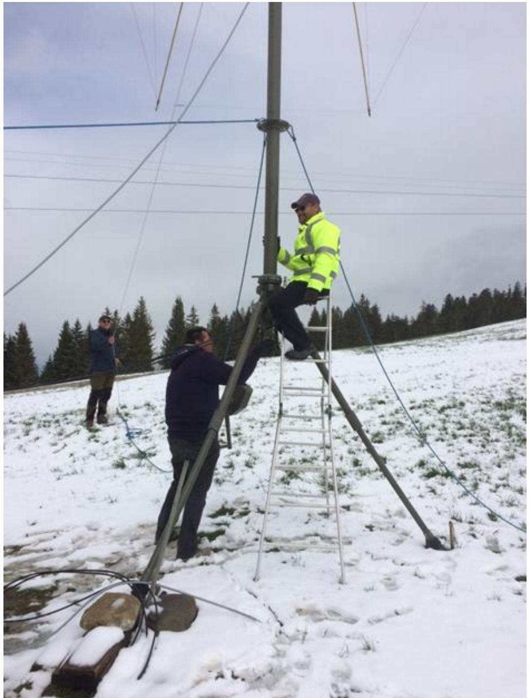
Abbau der Quad-Antenne im Schnee
